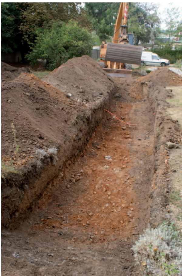
Figure 10 - Vue d'ensemble du sondage 2 depuis le sud-est
