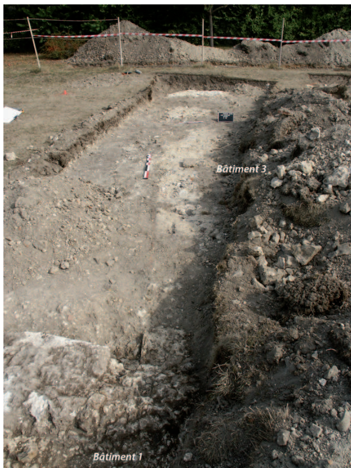
Figure 54 - Les maçonneries du bâtiment 3 et leur raccordement au bâtiment 1, vus de l'ouest
