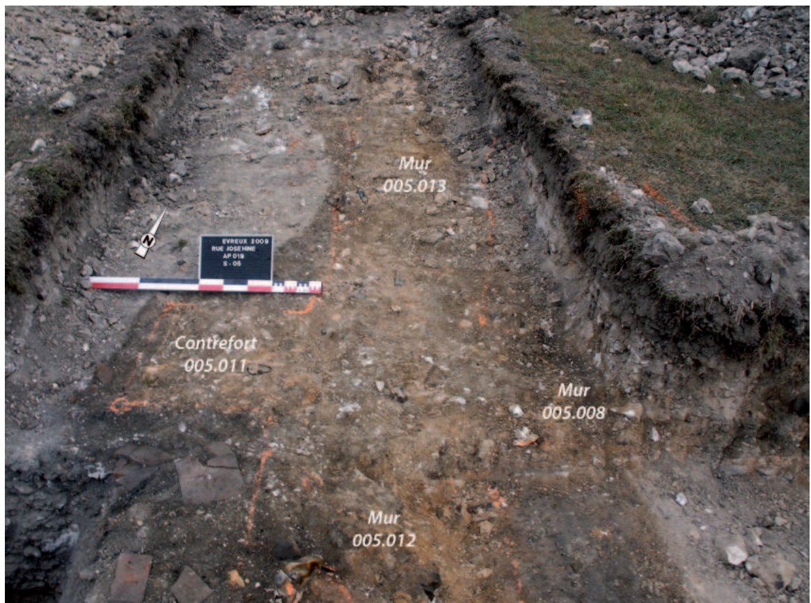
Figure 39 - Vue de l'angle sud-ouest du bâtiment 1, depuis le sud
