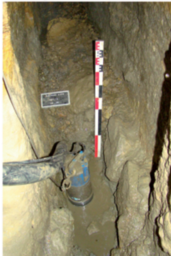
Fig. 4-4 : canalet au pied de la galerie souterraine
