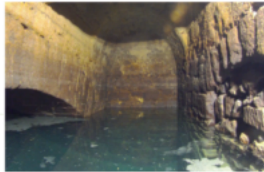
Fig. 6.2 : vue partielle de la citerne
