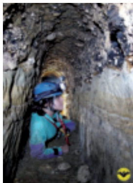
Figure 8 : exemple de cuniculus antique creusé au niveau du joint de strate pouzzolane-tuf (Italie). cl. Web.
