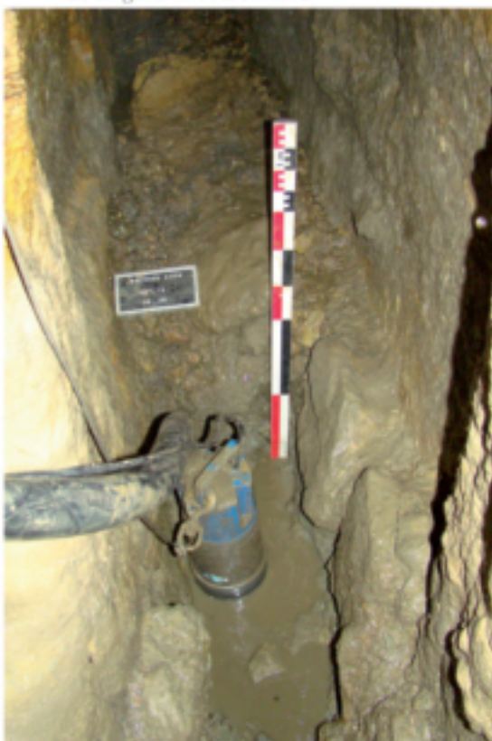
Fig. 4-4 : canalet au pied de la galerie souterraine
