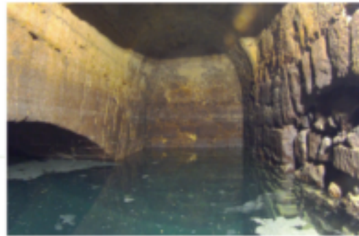
Fig. 6.2 : vue partielle de la citerne
