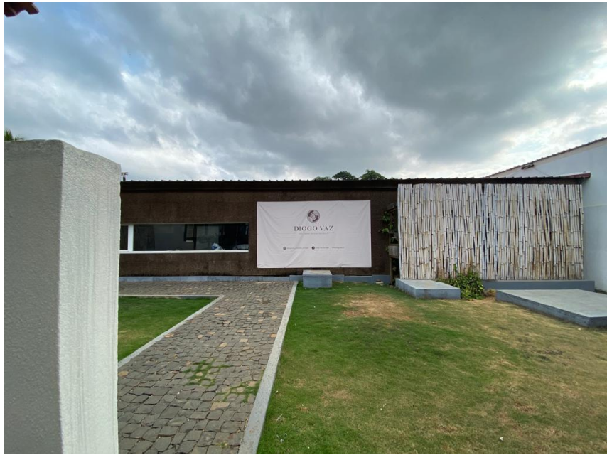
Illustration 25 : Locaux où le chocolat est fabriqué ©IrèneDosSantos (mai 2023 ; je n'ai pas été autorisée à photographier l'intérieur du bâtiment)
