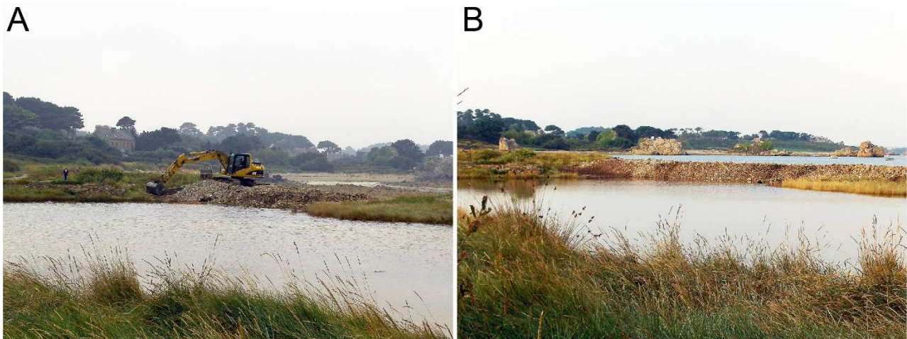
Figure 79 – Reprofilage et redressement du sommet du cordon n° 7 à la pelle mécanique le 9 septembre 2014. A. Opération en cours. B. Cordon après reprofilage (source : Anne-Sophie Moreau).
