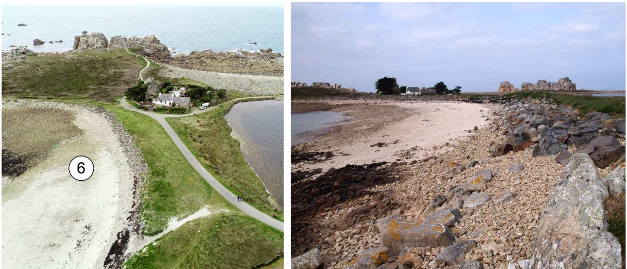
Figure 10 – Vues obliques du cordon de galets n° 6 (voir figure 6 ) montrant la présence de l'enrochement qui fixe le trait de côte. Photos aériennes obliques prises au drone le 18 mars 2021. Source : J. Ammann (10a) ; G. Stéphan (10b).
