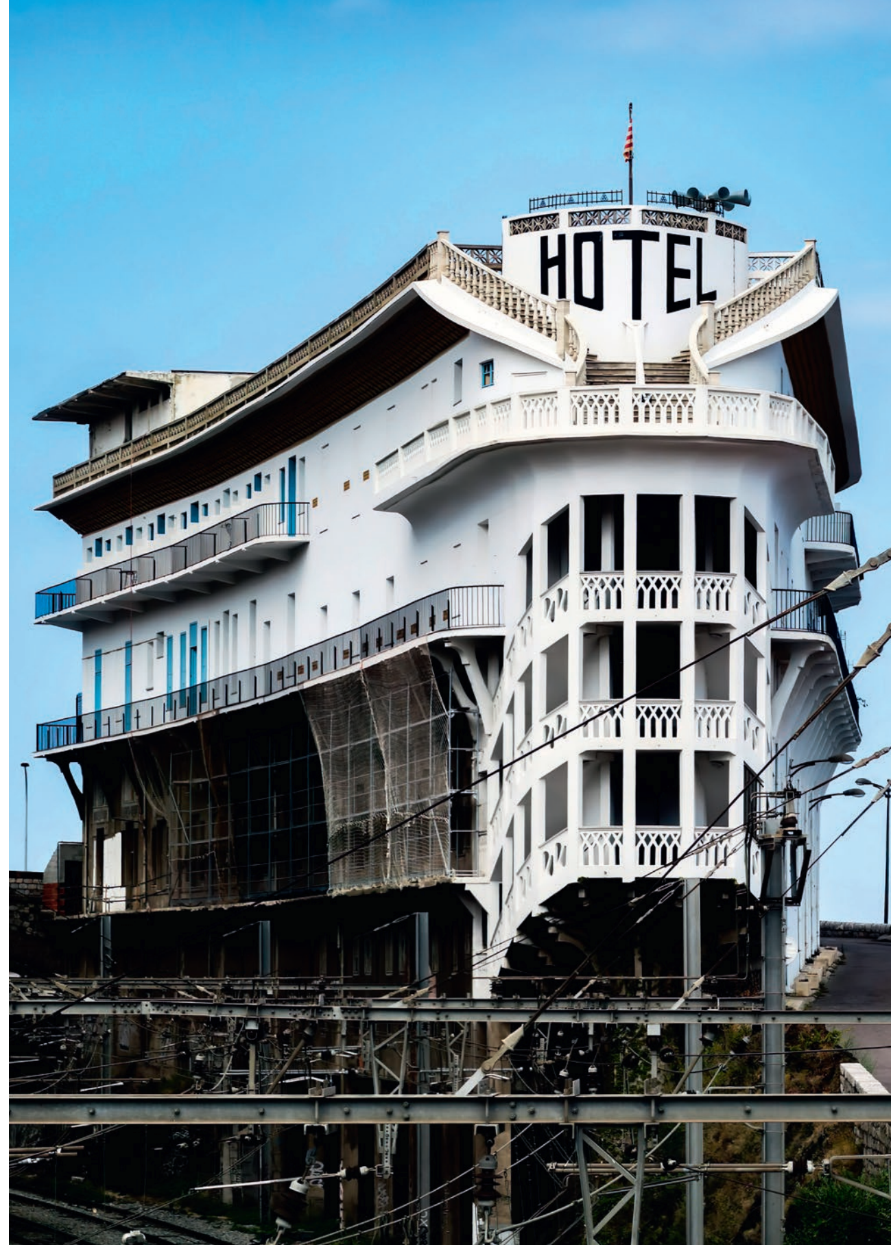
Hôtel Le Belvédère du Rayon-Vert à Cerbère, de l'architecte Léon Bailly, inauguré en 1932
