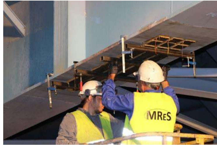
Application sur le pont Jarama (projet FASSTbridge)
