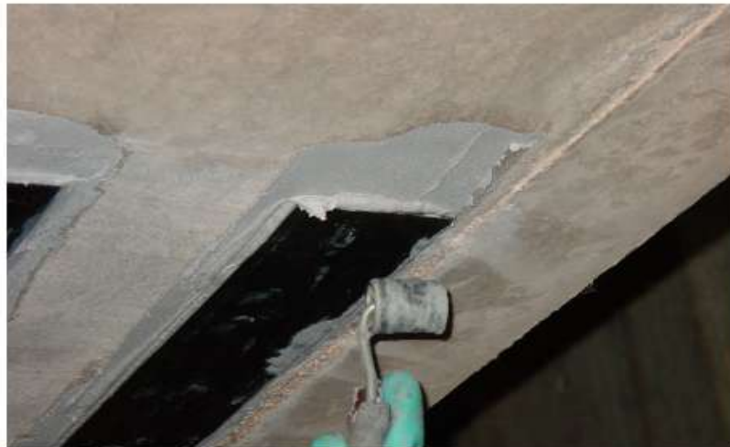
Plat composite pultrudé collé sur site
