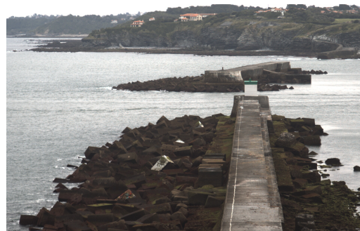
FIGURE 4 – Vue de la digue de l’Artha.
