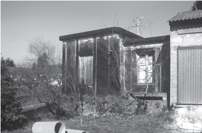
Maison Fillod – 23 rue d'Allonval – Saint-Amour (Jura)
