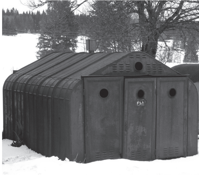
Bâtiment Fillod à usage de garage Morbier (Jura)
