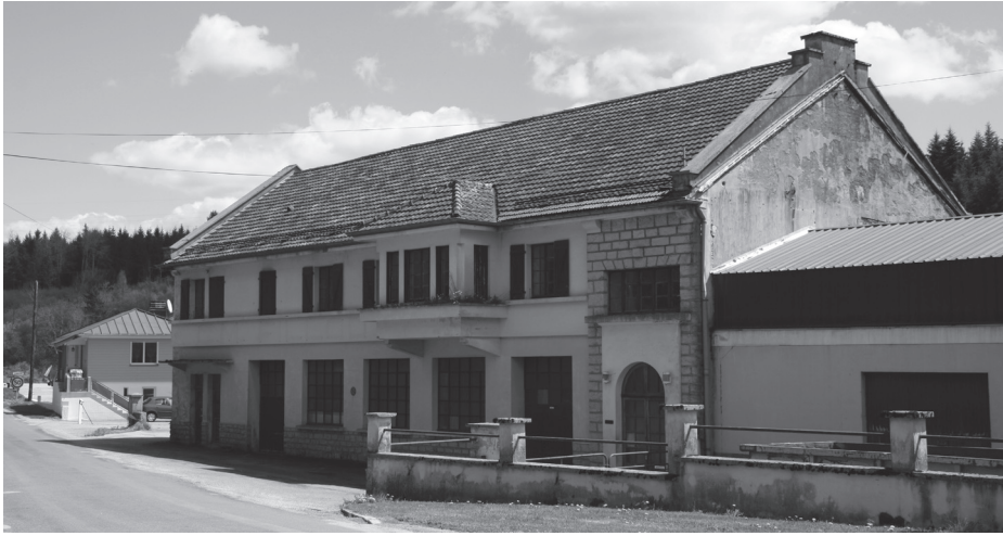
Usine Fillod à Ardon (Jura) Photo Francis Péroz.
