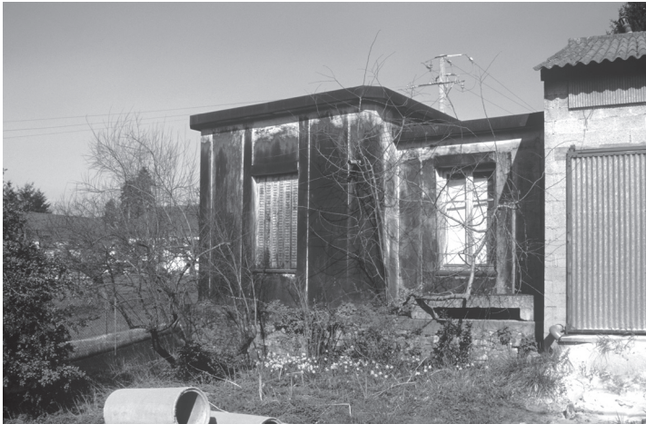
Maison Fillod – 23 rue d'Allonval – Saint-Amour (Jura)
