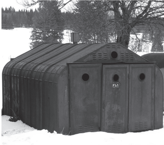
Bâtiment Fillod à usage de garage Morbier (Jura)
