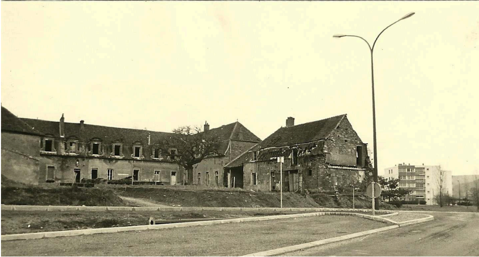
Fig. 3 – Vue générale des bâtiments annexes de la fin du XVIII e siècle, situés en périphérie occidentale du complexe religieux avant leur réhabilitation en centre social en 1976 (cl. C. Sapin).
