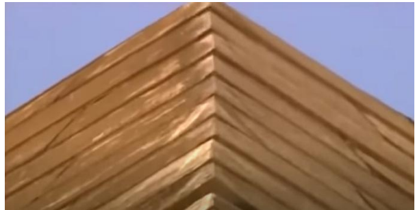
Vue peu commune 358 , par le dessous, du sommet de la pyramide de Khephren. Les assises sont largement décalées entre elles, preuve que la taille et le surfacage de chaque bloc étaient déjà réalisés avant sa pose. Il n'y avait qu'une seule possibilité pour celle-ci : livrer les blocs à l'intérieur et les pousser vers l'extérieur.
