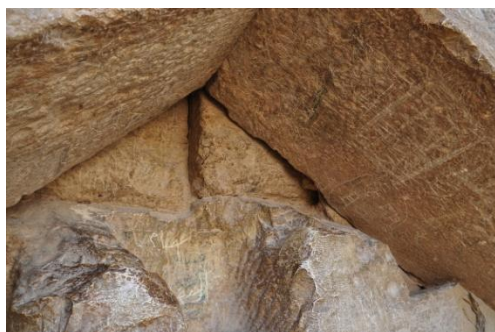
Vue de la maçonnerie posée sur la Herse. Les deux blocs ne sont pas alignés à cause des conditions de leur pose.
