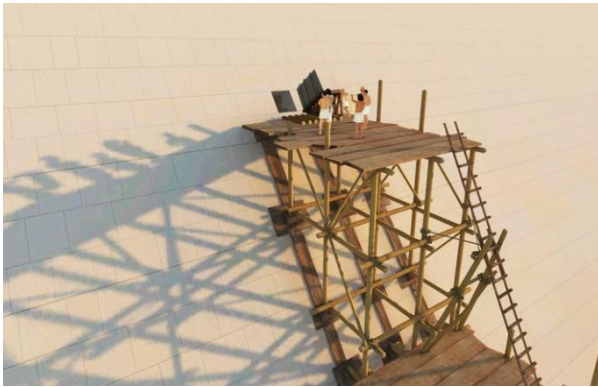
L'échafaudage en bois extérieur permettant d'accéder à l'entrée unique dans la pyramide. Le bloc de calcaire de Tourah scellant le couloir descendant a été installé avant les funérailles sur un portique incliné posé sur des rouleaux.
