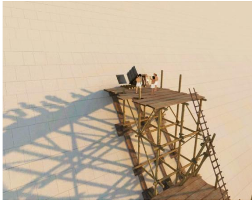
L'entrée de la pyramide et son échafaudage
