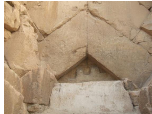
Photo de la Pierre de Strabon insérée sous la paire de chevrons inférieurs. Sur la gauche, le pied d'un chevron brisé est visible.
