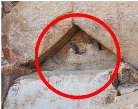
La Pierre de Strabon en gros plan. La partie comportant les « crans » n'est pas en contact avec les chevrons, pouvant être en contact avec une cavité. (Pour rappel, l'endoscope qui a permis de visualiser la seconde chambre a été introduit par un interstice).
