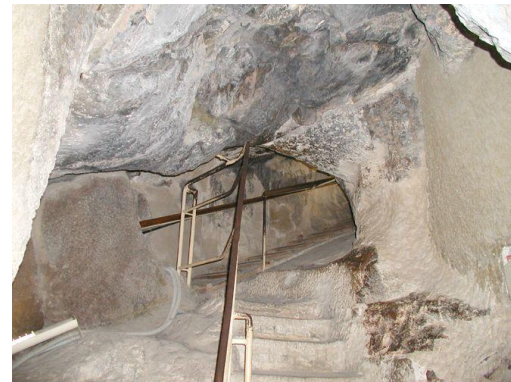
Vue, depuis la sape creusée par les pilleurs, du troisième bloc-bouchon, en partie brisé, en amont du second. Un puits a été creusé reliant les deux couloirs.
