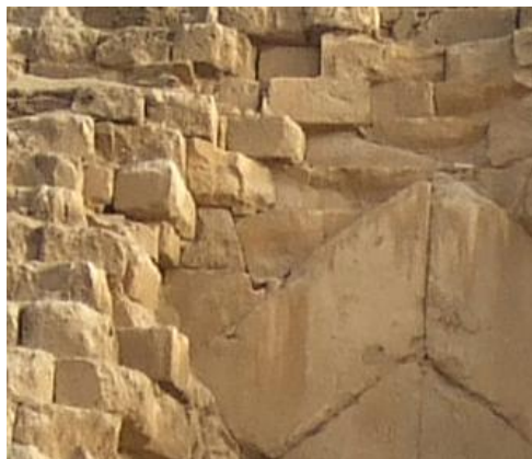
Appareillage des blocs au-dessus du chevron haut gauche
