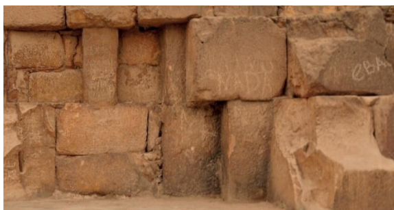
Gros plan sur la maçonnerie, visiblement remaniée, dans la zone où l'anomalie a été détectée.
