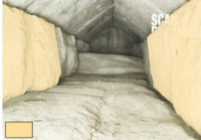
Les blocs du système de contrepois. Avant l'abaissement de la Herse, ils étaient repoussés jusqu'au niveau de la poutre traversant la chambre.
