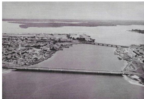
Au fond le premier pont Félix Houphouët-Boigny livré en 1957. Au premier plan, le pont Charles de Gaulle livré en 1967, année de la photo.
