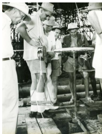
Photo d'une réunion de chantier au-dessus d'un pieu du premier pont d'Abidjan datant du milieu de l'année 1955. Mon père est la seconde personne en partant de la gauche et André Ferré, le directeur des travaux du pont et futur membre du Collège d'Experts est au centre, de face. À l'époque, les moyens techniques de contrôle étaient simples ; maintenant, l'informatique a révolutionné les chantiers.
