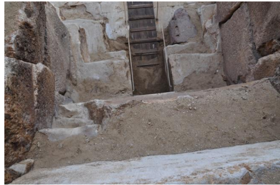
Vue plongeante depuis la plateforme devant la Pierre de Strabon sur le couloir descendant. Des banquettes latérales de 2 coudées chacune de part et d'autre du couloir descendant laissent un puits de 3 coudées axé sur le couloir de 2 coudées de largeur. La coudée restante était répartie de chaque côté du couloir descendant pour créer des appuis pour des dalles de fermeture.
