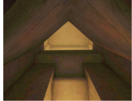
Le décaissé dans la paroi du fond du puits de liaison vers la seconde chambre.
