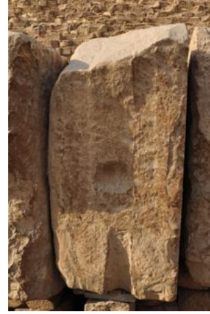
Gros plan sur un trou et une rigole creusés sur une face latérale d'un côté d'une poutre.
