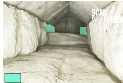
Les blocs déjà à leur place définitive. Ces blocs sont ceux posés à partir de la poutre traversant la chambre jusqu'au fond de celle-ci.
