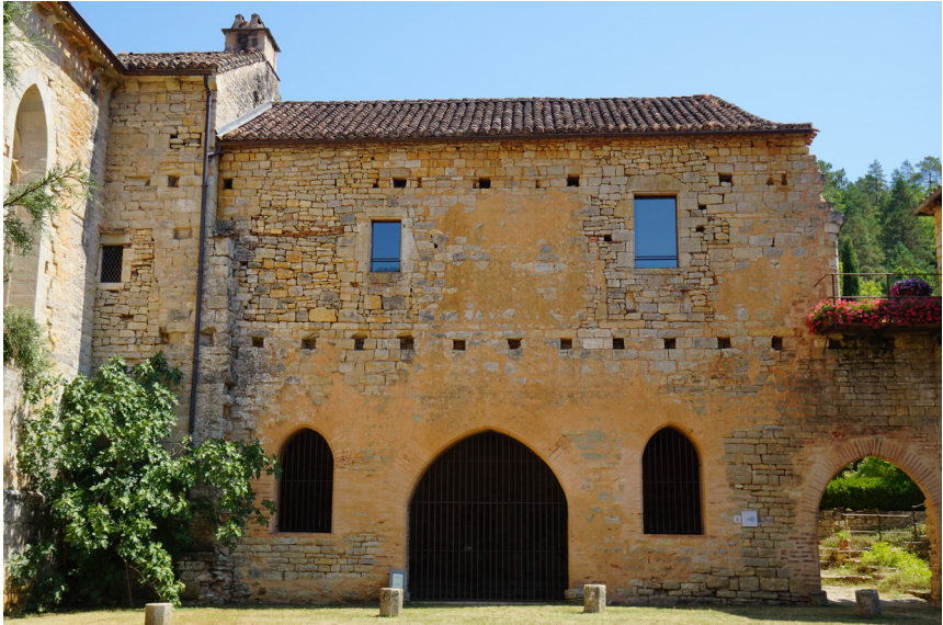
Fig. 14 – Les Junies (Lot), bâtiment oriental vu du cloître (XIV e siècle) : le rez-de-chaussée était utilisé comme salle du chapitre. © Haude Morvan.
