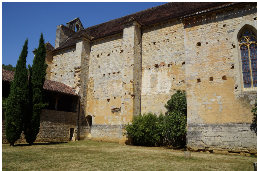
Fig. 17 – Les Junies (Lot), mur gouttereau de l'église vu depuis le cloître : on notera les deux portes (dont celle de l'étage est aujourd'hui murée) dans la seconde travée, appuyées sur le contrefort. © Haude Morvan.
