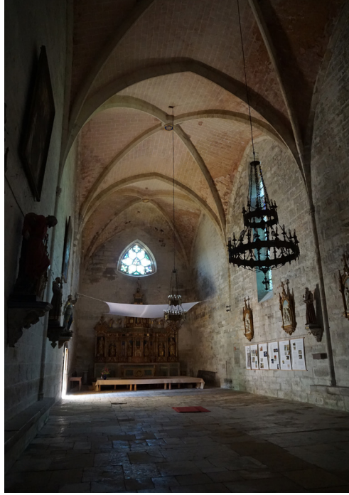
Fig. 16 – Les Junies (Lot), actuelle église Saint-Pierre-ès-Liens (anciennement église des dominicaines), vue intérieure vers l’ouest : on notera les banquettes en pierre dans la troisième travée, et les demi-colonnes recevant la retombée des ogives entre la première et la deuxième travée qui s’interrompent à mi-hauteur par des culots. © Haude Morvan.
