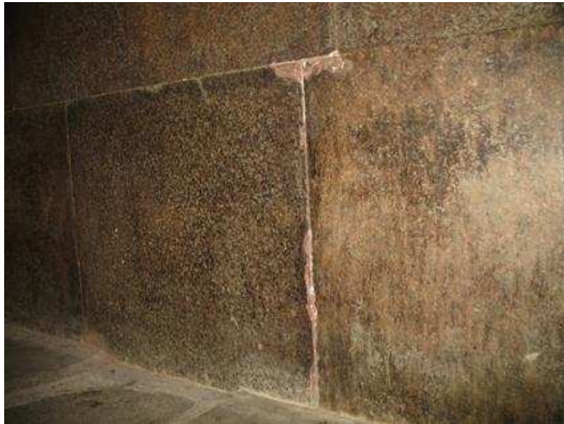
Joint large à droite du bloc bouchant la 2 ème entrée. Une analyse in-situ montre que ce bloc n'est pas parfaitement aligné avec les autres blocs du mur nord.
