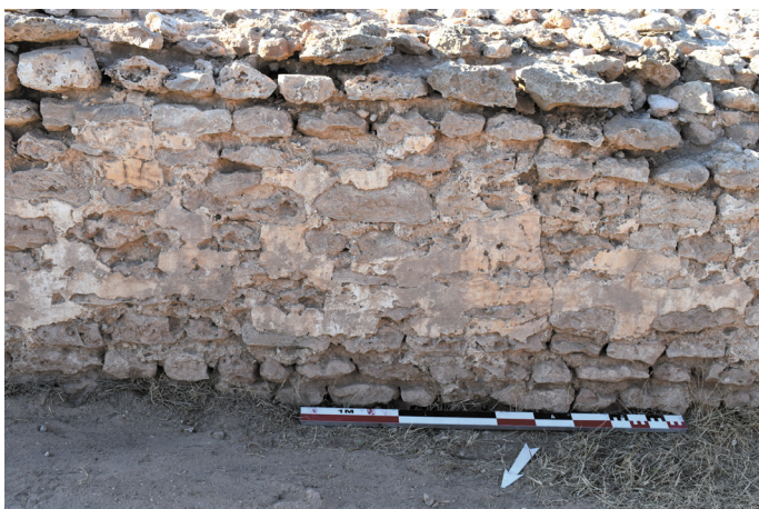
Fig. 8 : Thaenae . Secteur 3. Traces d'enduit sur le parement extérieur du rempart (cliché M. Bonifay, 2022).
