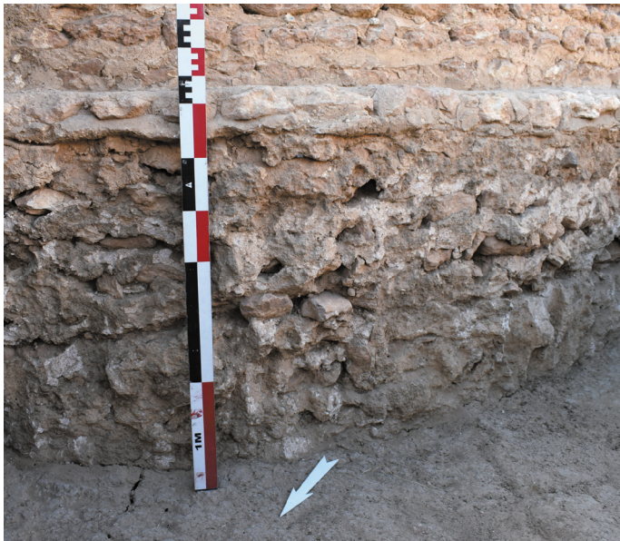
Fig. 6 : Thaenae . Secteur 3. Fondations et semelle de la tour 1, face externe (cliché M. Bonifay, 2021).
