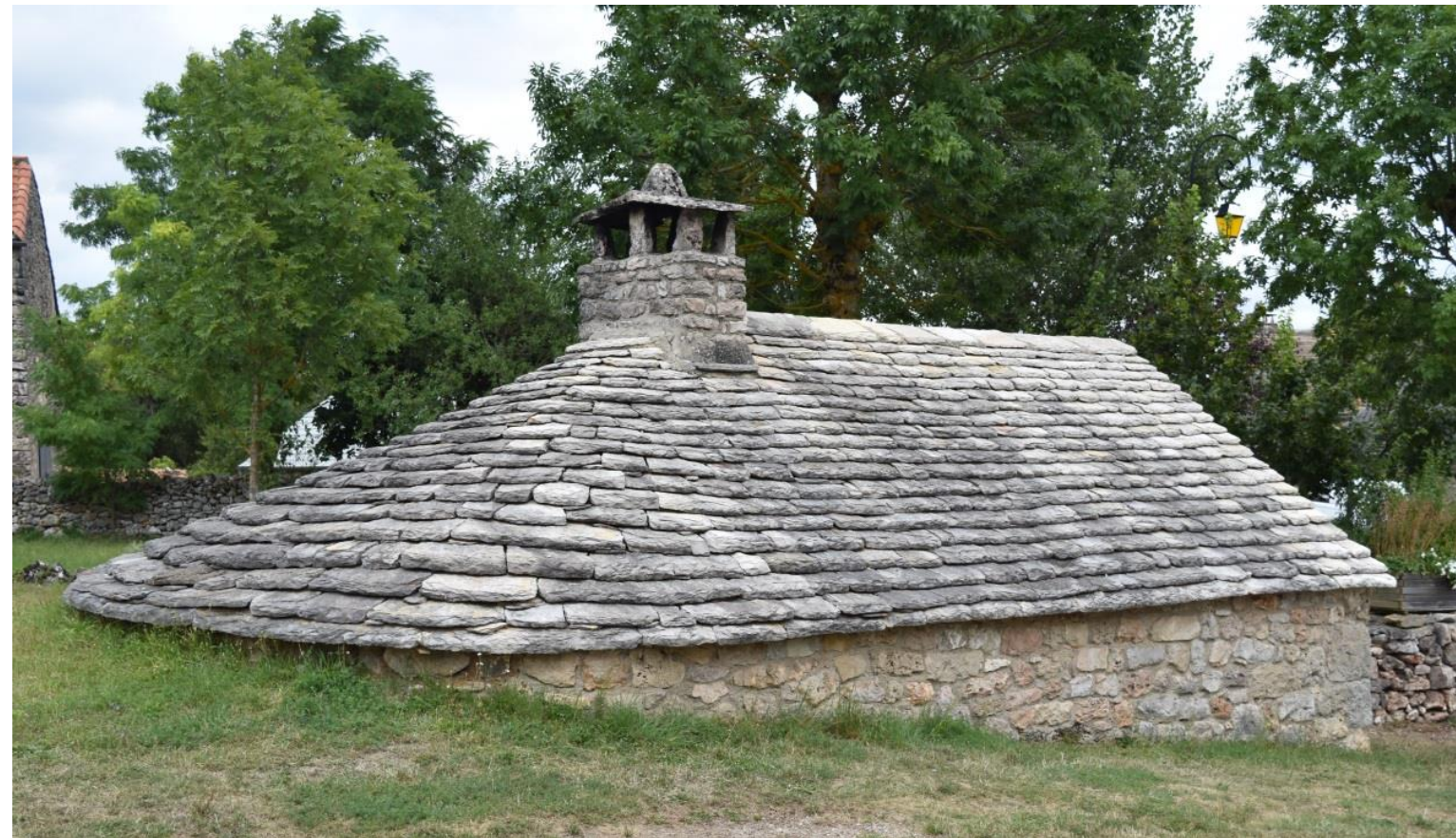
Four à pain couvert en lauzes calcaires en Aveyron (Photo FogueDjombou)
