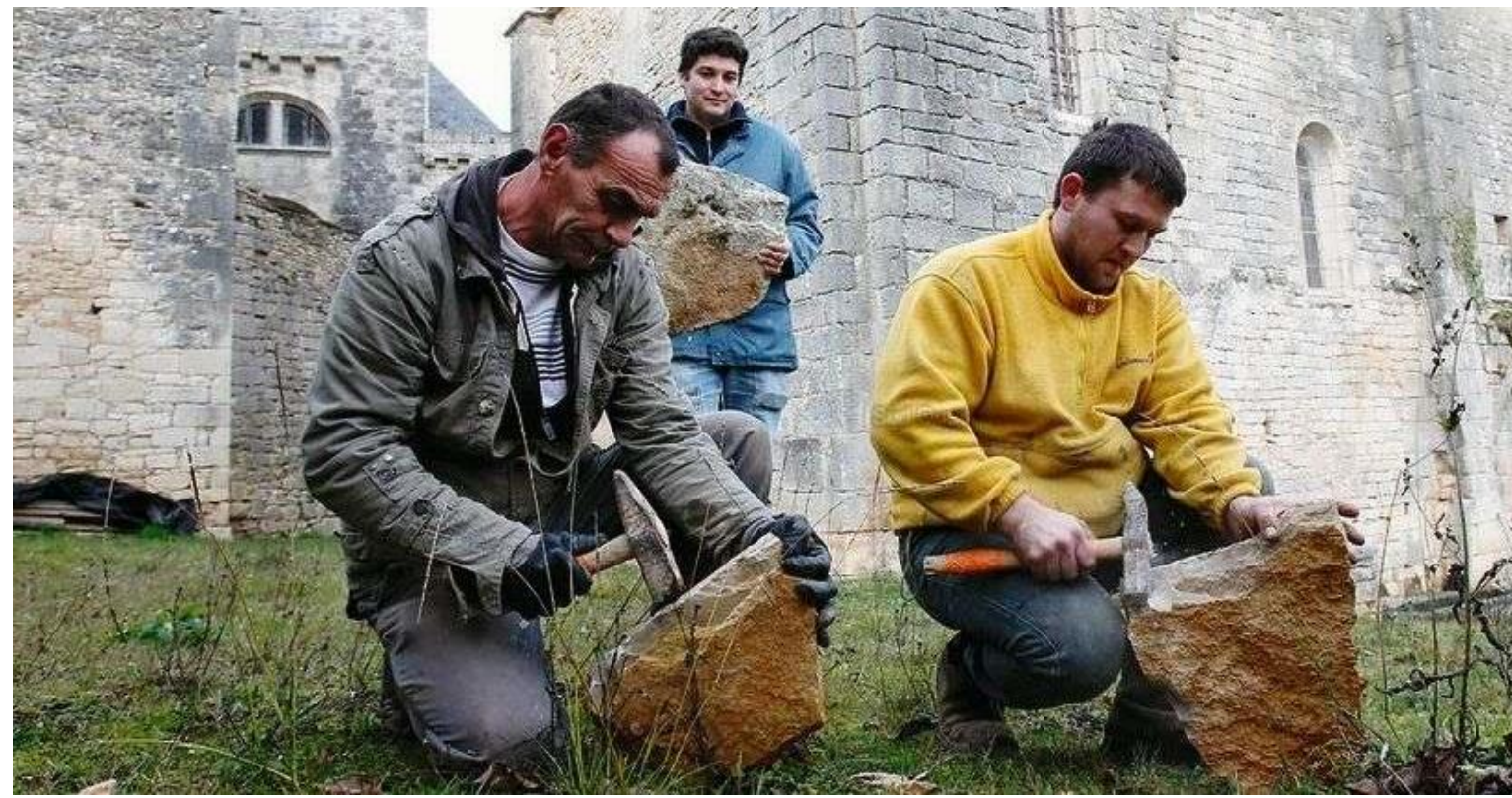
Technique artisanale de taille, diagnostic et sélection des lauzes (Photo Sounalet)
