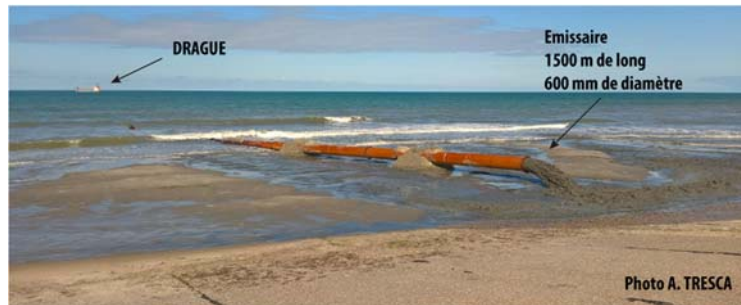
Figure 6. Illustration du rechargement par le by-pass installé en 2019.
