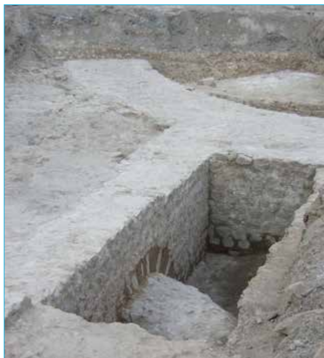
Fig. 25 : possible castellum de l'aqueduc, dans le sondage effectué au Péchin (cliché C. Franceschelli).
