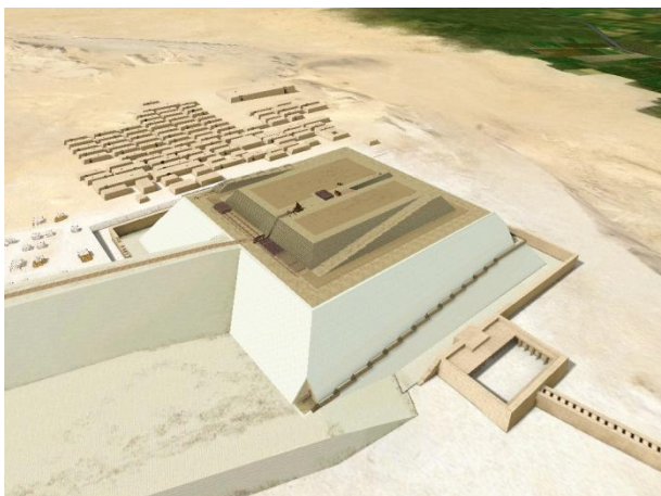
Aspect de la pyramide dans la version de 2007 lors de la construction du 3 ème plafond. Le chantier de construction du volume est suspendu en périphérie au niveau +43m.
