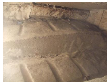
Sur la face supérieure des poutres beaucoup plus hautes que large, des engravures d'arrimage ont été creusées pour assurer la stabilité de l'ensemble.
