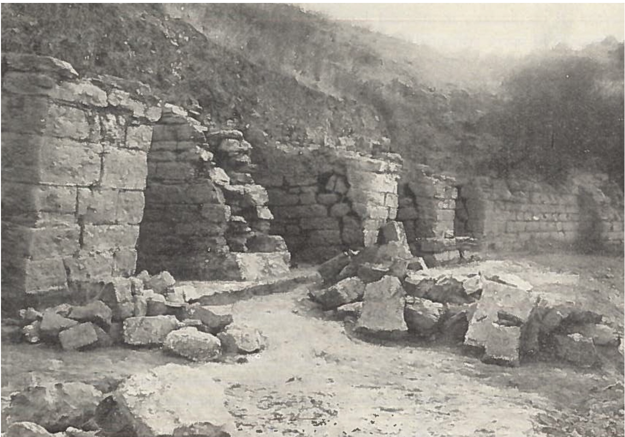
Figure 64 : Vue des contreforts en partie effondrés. © Caretoni 1959, fig. 32, p. 328.
