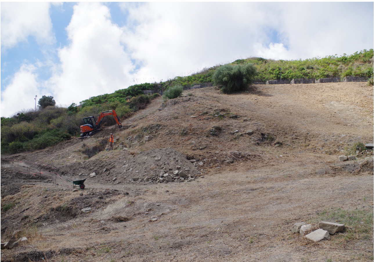
Figure 6 : Le secteur de l'angle sud au début de l'intervention de 2021. Ouverture dans les colluvions récentes d'une tranchée de retenue des pierres et des eaux de ruissellement. © Frédéric Gerber, 2021.
