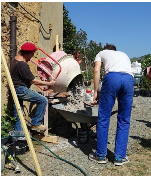
Figure 4 : Monique (au chapeau rouge) montre comment « faire » la première bétonnière, de l'incorporation des matériaux (chaux, paille, eau) à la sortie de la matière préparée (juillet, 2022) (F. Widmaier ©).
