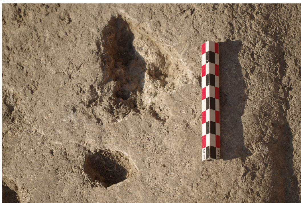
Figure 18 : Vue de détails des traces de pic ou de pioche sur l'assise du siège de théâtre (Usc 30.047). © Frédéric Gerber, MAFHA.
