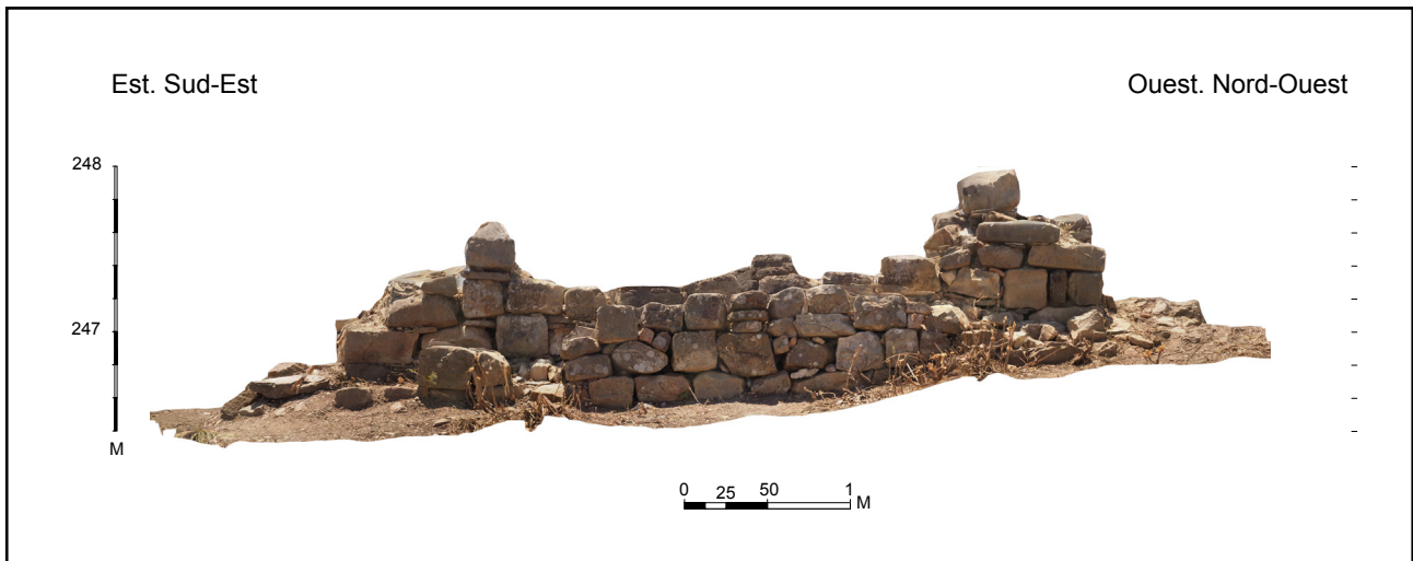
Figure 33 : Orthophoto de la face septentrionale réalisée à partir du levé photogrammétrique. © Vincent Miaillhe, MAFHA.
