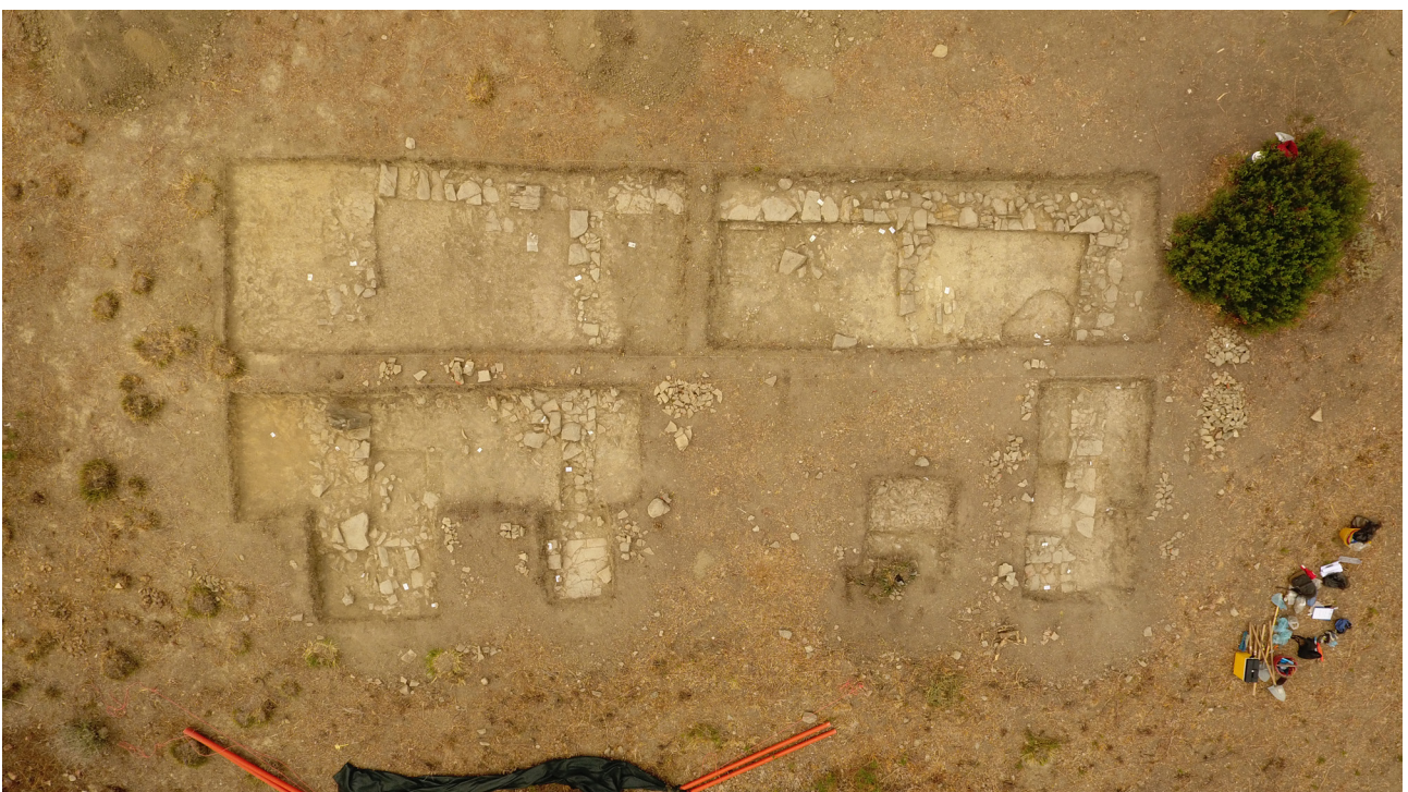
Figura 8 : Edificio completo. © MAFHA / Cédric Corre.
