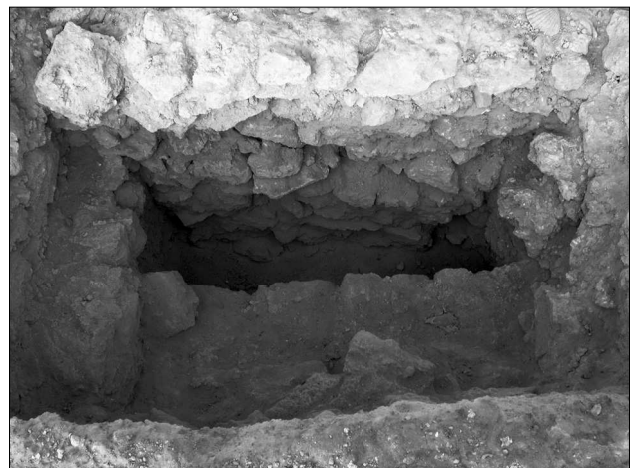
Fig. 277 – Le mur ouest de B119, phase 5, et sa fondation en pierre sèche dans les couches médiévales, sondage 119B.
