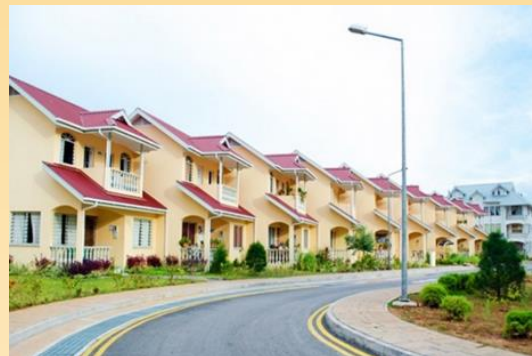
Photo 1. Projet (réalisé) du « village des jeux » (Seychelles)
