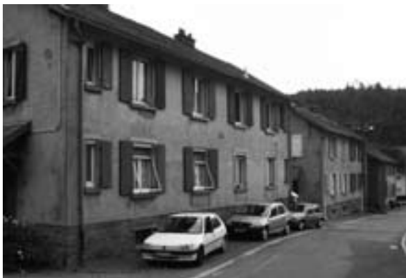
La cité Saint-Pierre à Giromagny est un exemple des logements construits après le retour de la concurrence dans le Rosemont
