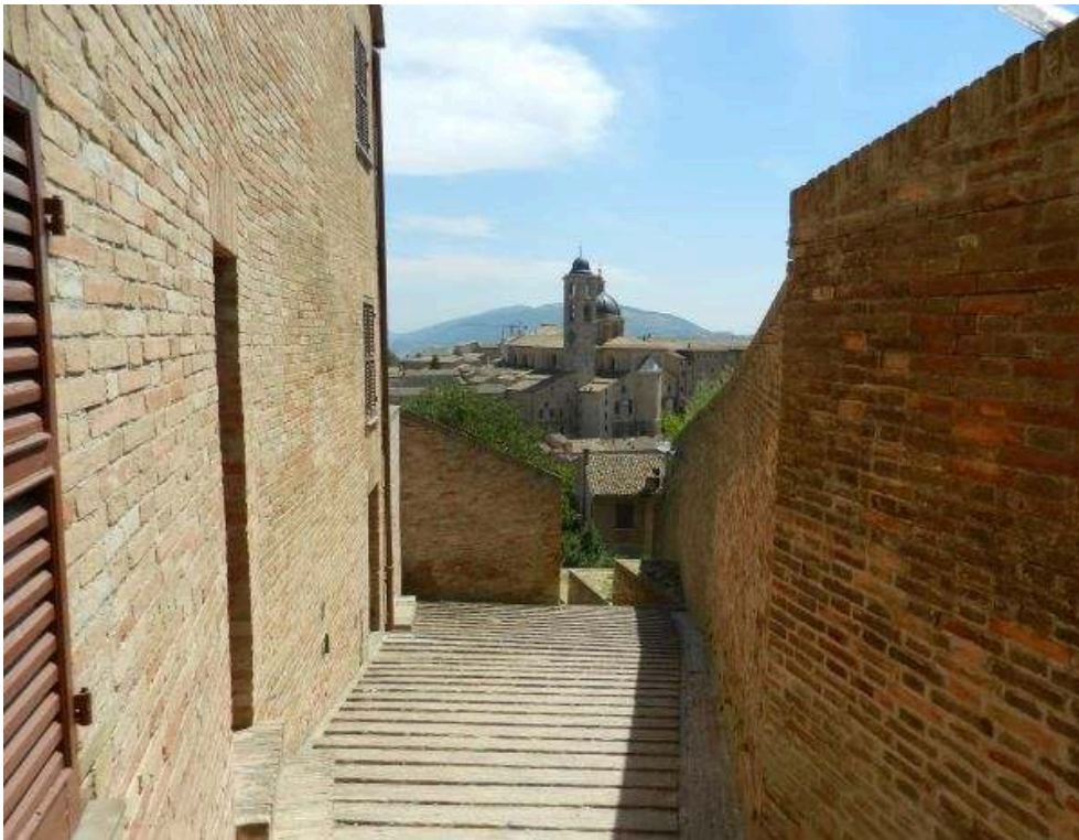
Figure 7. La brique est utilisée pour réaliser les édifices, mais aussi les revêtements des rues, les murs de soutènement et les fortifications du centre-ville.
