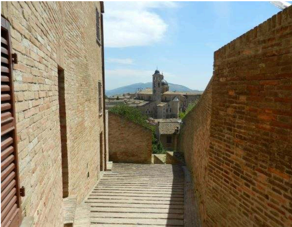
Figure 7. La brique est utilisée pour réaliser les édifices, mais aussi les revêtements des rues, les murs de soutènement et les fortifications du centre-ville.
