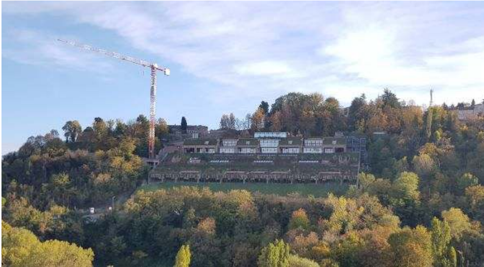
Figure 26. Sur le fond, la nouvelle structure du parking enterré de la Porta Santa Lucia , réalisé en 2016.
