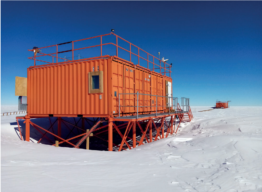
Figure 8. Container Atmosphère. Photo : Institut polaire français.
