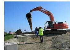
Les tuyaux sont assemblés par soudure à l'arc électrique, deux par deux, et seront déposés sur la plage, en attendant l'assemblage final.
