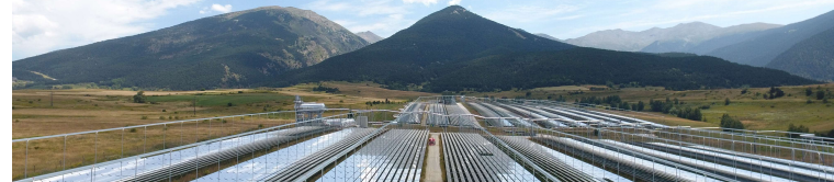
Figure 2 : Photo de la centrale solaire eLLO
