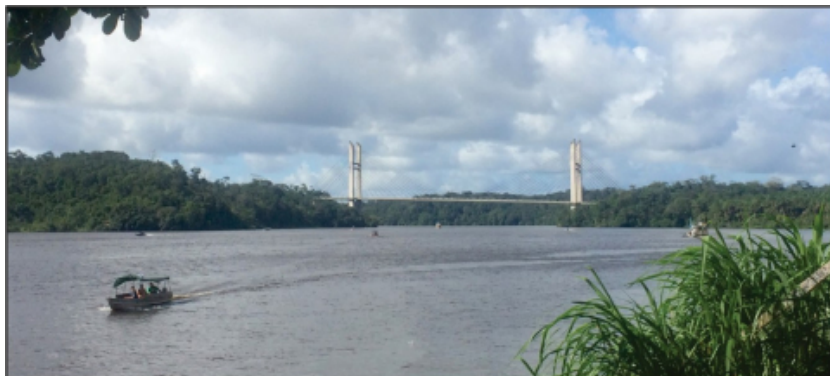
Photographie 03 : Pont sur le fleuve Oyapock - frontière entre la Guyane française et le Brésil
