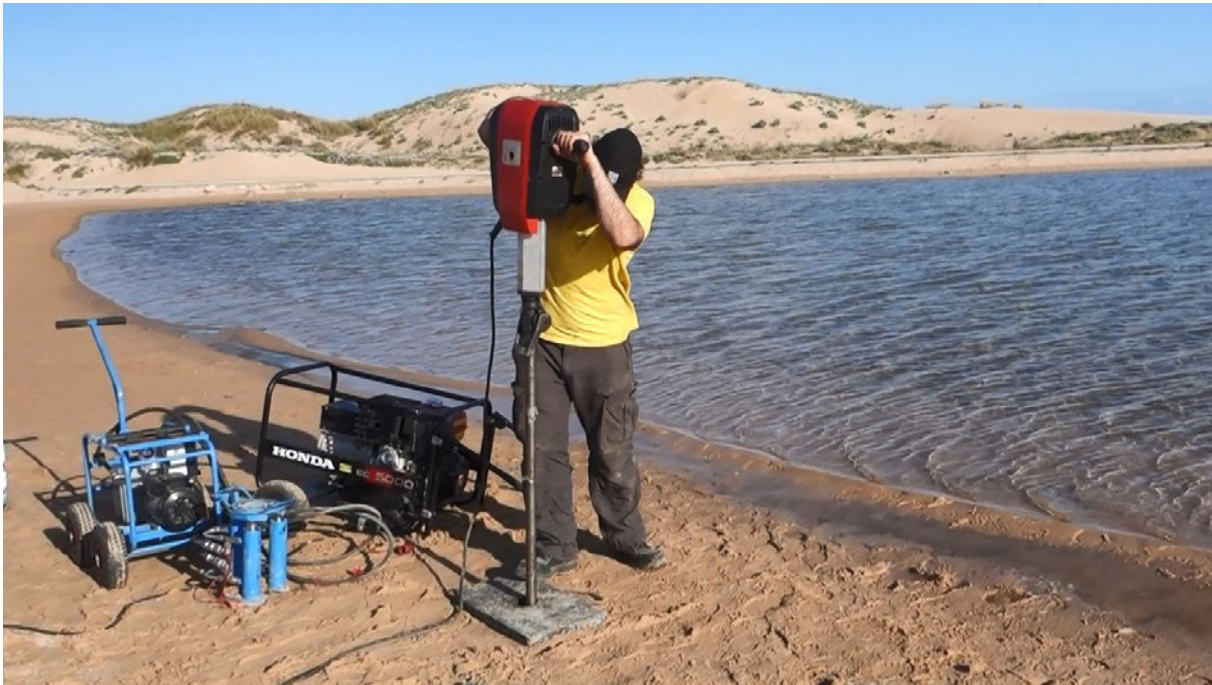
Figura 3. Sondeos geotécnicos realizados con un percutor portátil
