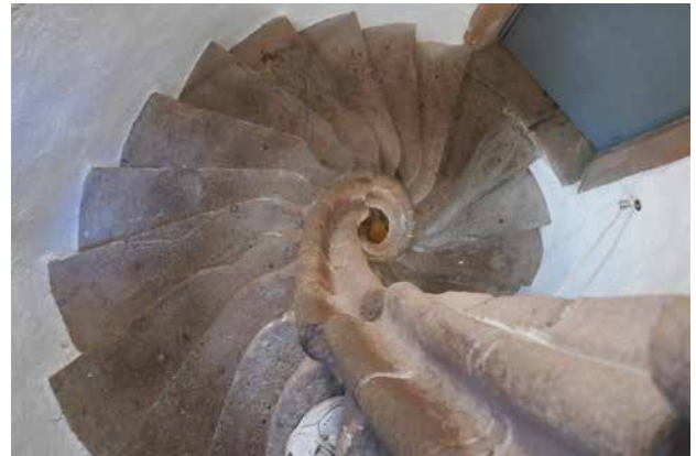
Figure 2 – Escalier à vis dans une tourelle d'une maison de maître mineur du XVI e siècle, au 12 rue Weisgerber / Wendeltreppe in einem Türmchen eines Herrenhauses eines Bergmeisters aus dem 16. Jahrhundert, 12 rue Weisgerber . Cliché © P. Fluck 3
