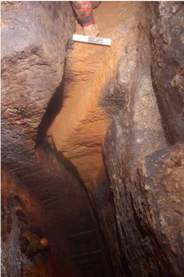
Abb. 16 – Eingeschlagelte Luttenleitung / Conduit d'aéragage taillée dans la roche . Grube St. Lampertus in Hohenstein-Ernstthal. Foto © Sven Schreiter
