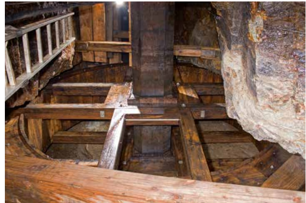
Abb. 13 – Ehrenfriedersdorf; Alexander Schacht, Kunstradstube aus dem 16. Jh. mit neu eingebautem Kunstgezeug oberhalb vom Tiefen Sauberger Erbstolln / Alexander Schacht, chambre de roue du 16 e siècle avec des équipements hydrauliques récemment installés au-dessus de la galerie profonde de Sauberger Erbstolln. Foto: © J. Kugler, 2009
