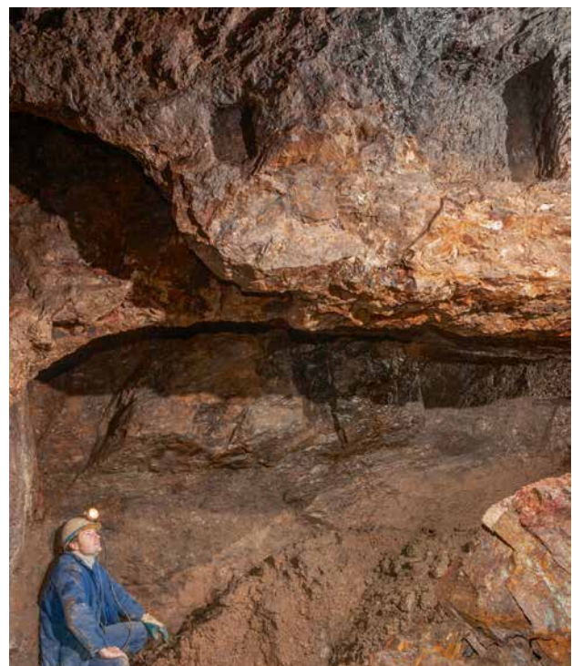
Abb. 8 – In diesem Bereich sieht man einen Teil der Kunstradstube mit beachtlichen Bühnlöchern in den Stößen / Dans cette zone, on voit une partie de la chambre de roue avec des encoches de poutres remarquables dans les parois. Foto © J. Kugler, 2005
