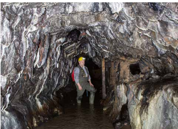
Abb. 14 – Hölzerne Wetterlutte / Buse d'aérage en bois . Gonnaer Stolln bei Wettelrode. Foto © Jens Kugler
