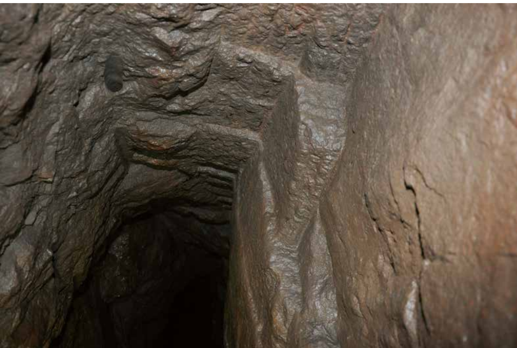
Figure 7 – Technique mixte: pointerolle (paroi droite) poudre (paroi gauche) détail / Mischtechnik: Bergeisen (rechte Wand) Pulver (linke Wand) Detail
