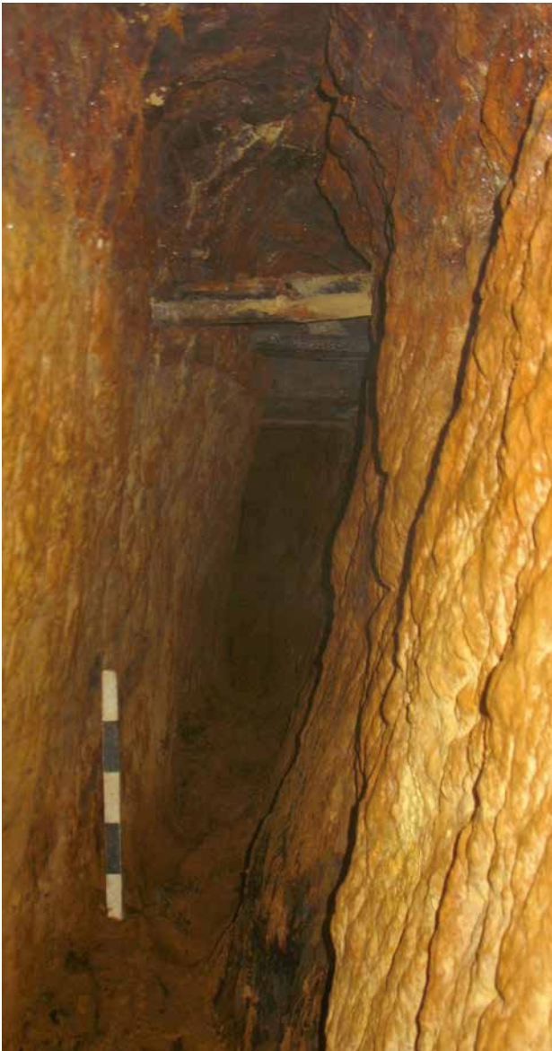
Abb. 12 – Wetterscheider / Plafond d'aérage. Grube Teufelsgrund im Münstertal/Schwarzwald, dat. 1411. Foto © Martin Straßburger
