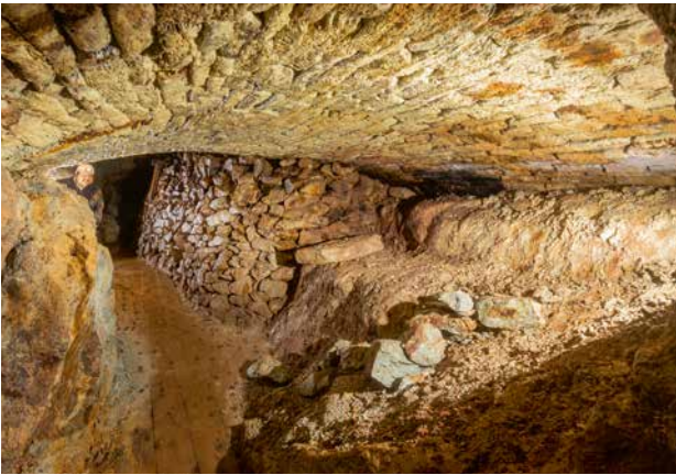
Abb. 1 – Freiberg; (Alte) Reiche Zeche Richtschacht im Niveau des Tiefen Fürstenstollns. Über diesem trocken gesetztem Bruchsteingewölbe befand sich mindestens eine, unter Martin Planer im 16. Jahrhundert errichtete, Kunstradstube / Freiberg ; (Alte) Reiche Zeche Richtschacht au niveau de la galerie profonde Fürstenstollen. Au-dessus de cette voûte en pierres sèches se trouvait au moins une salle des machines construite sous Martin Planer au XVI e siècle. Foto © J. Kugler, 2018
