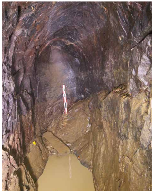
Figure 4 – Front de taille du travers-bancs d'exhaure de Reichenberg aux parois arrondies enduites de noir de fumée / Ortsbrust des Reichenbergers Wasserlösungsquerschlag mit abgerundeten. Photo © B. Bohly
