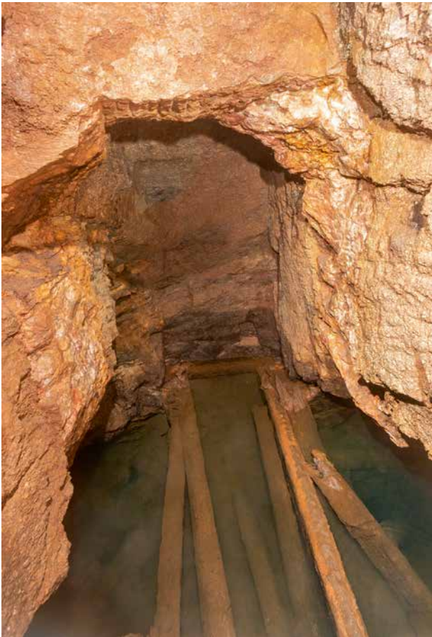
Abb. 15 – Seelitz; Kunstradstube von 1556 im St. Johannes Stolln am Vogelsang / Seelitz ; chambre de roue de 1556 dans la galerie St. Johannes Stolln à Vogelsang. Foto: © J. Kugler, 2018
