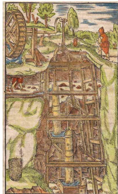
Abb. 11 – Wasserrad mit dem Ehrenfriedersdorfer Kunstgezeug / Roue à aube avec machinerie hydraulique . Abb.: Georgius Agricola, De Re Metallica 1556, 6. Buch; Slg.: J. Kugler, Gr.-Nr. 136
