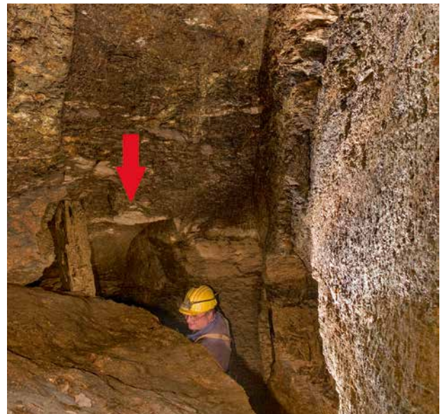
Abb. 14 – Elterlein; Kleine möglicherweise aus dem 16. Jahrhundert stammende Radstube über dem Lehnschafter Stolln / Elterlein ; petite chambre de roue datant peut-être du xvi e siècle au-dessus de la galerie Lehnschafter Stolln. Foto: © J. Kugler, 2010
