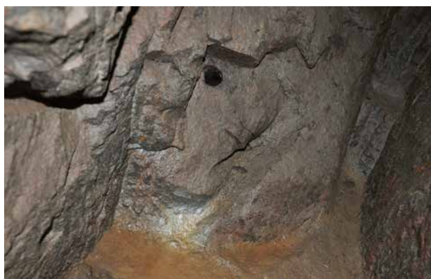
Figure 5 – Front de taille du début de la technique à la poudre noire avec travail préparatoire à la pointerolle / Ortsbrust aus der Anfangszeit der Schwarzpulvertechnik mit Vorarbeit mit Bergeisen.
