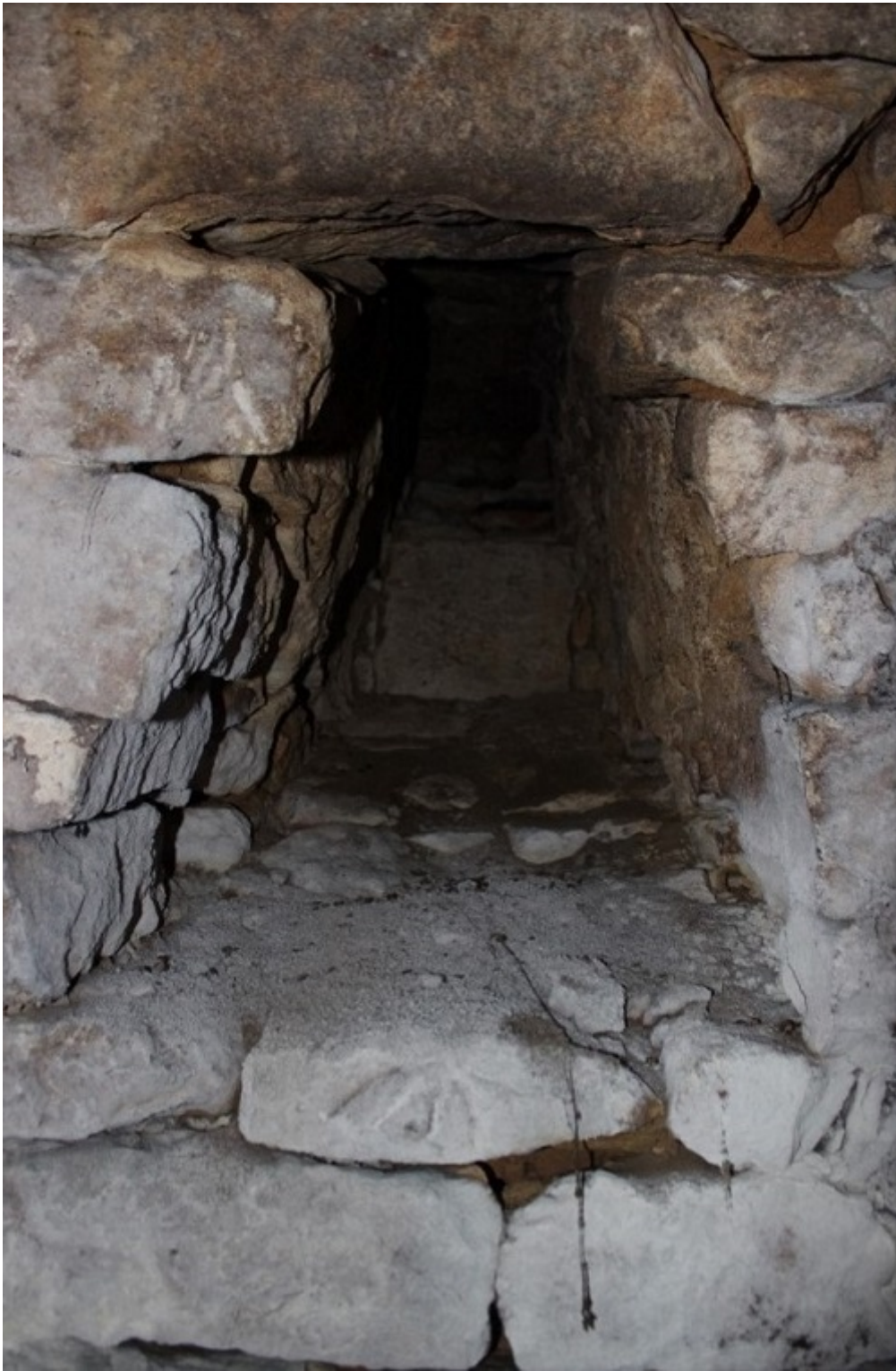
Fig. 8 : Vue de la profondeur de la fente de jour ainsi que de son bouchon © B. Merlet ( voir l'image au format original )
