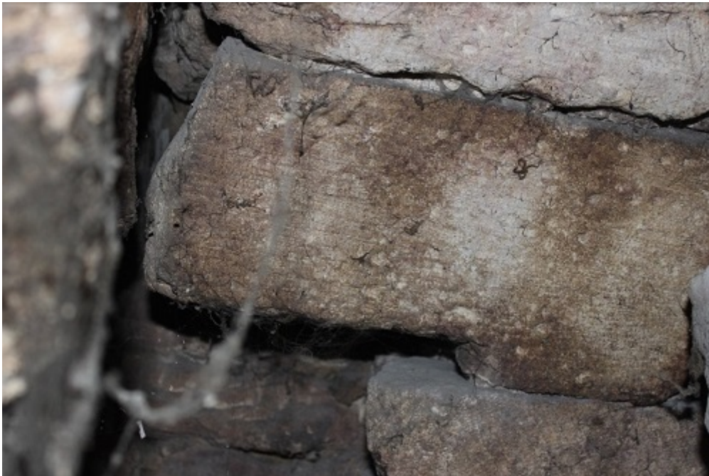
Fig. 12 : Détail des traces de layage sur un bloc de MR 3104 © B. Merlet ( voir l'image au format original )
