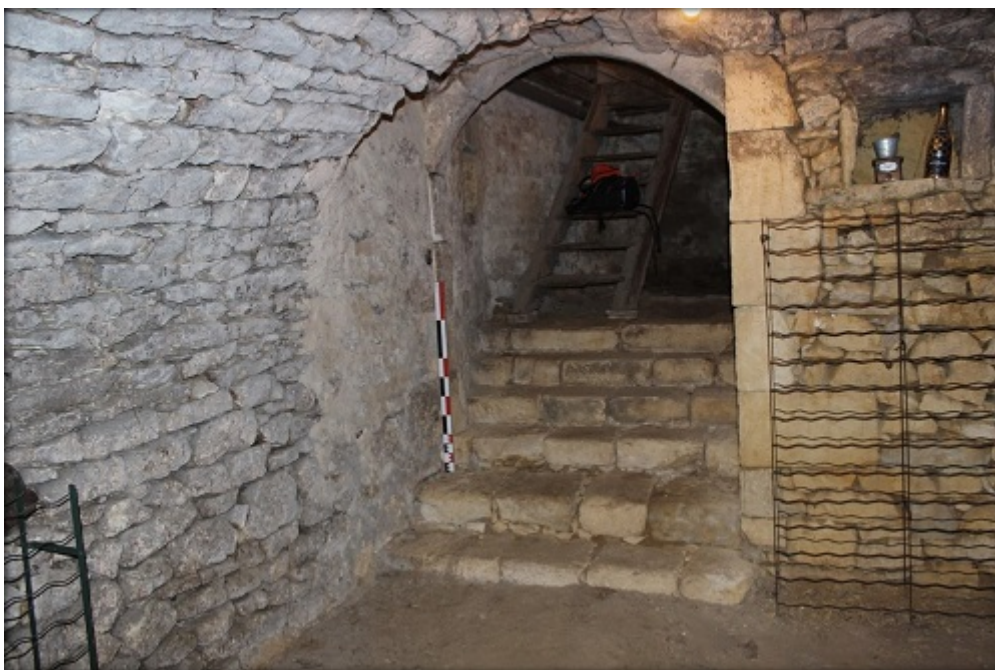
Fig. 17 : Escalier encadré par une porte (fait 8006) composée de deux piédroits (U.C. 8007 et U.C. 8006) ainsi que d'un arc © C. Armand (voir l'image au format original)
