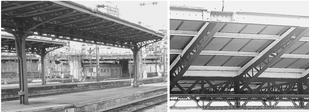
FIGURE 3 – Situation d’origine de la poutre treillis rivetée servant d’objet d’étude : les abris de quais de la Gare de l’Est à Paris. Photos : SNCF / AREP.
