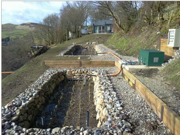
Exemple de remédiation en biomanipulant le système aquatique. Gauche: bassins de rétention végétalisés de phragmites, www.reedbeds.co.uk ; droite : installation de zones humides artificielles, le long d'un canal en amont d'un lac serbe pollué. D'après Rudic et al. 2018.
