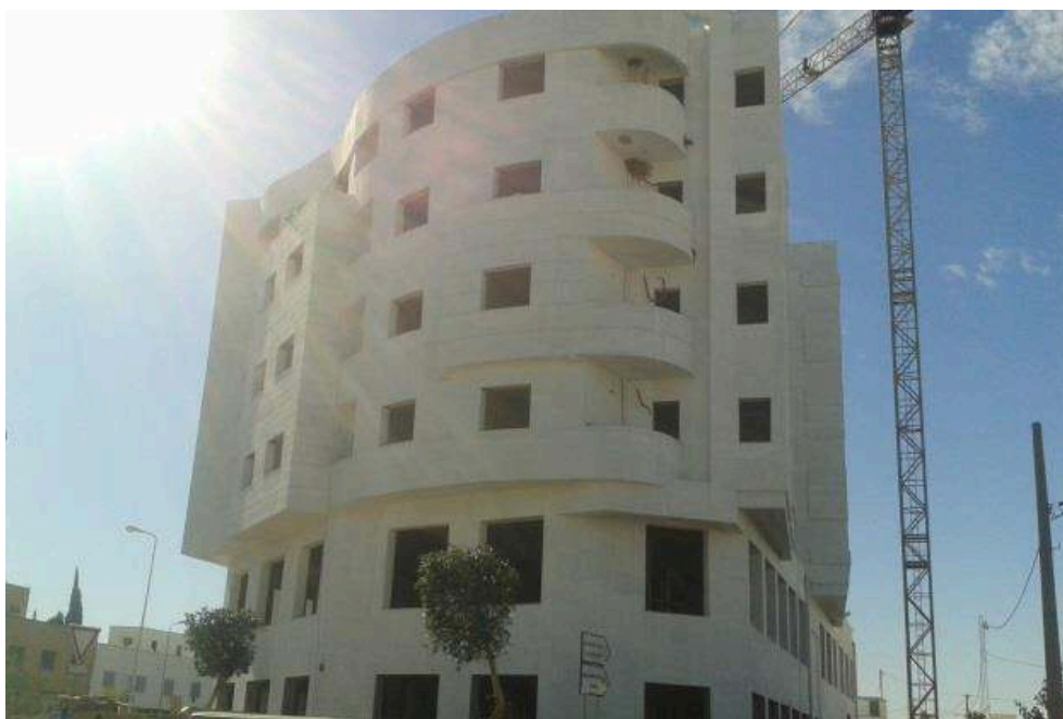
Photo 1 et 2 : Aménagements commerciaux et résidentiels en construction sur la route de Gremda
