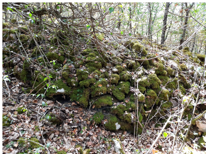
Figure 10: Prospection du secteur de la Vène (Puycelsi) : Mur de soutènement de tas d'épierrement au niveau du point n° 368
