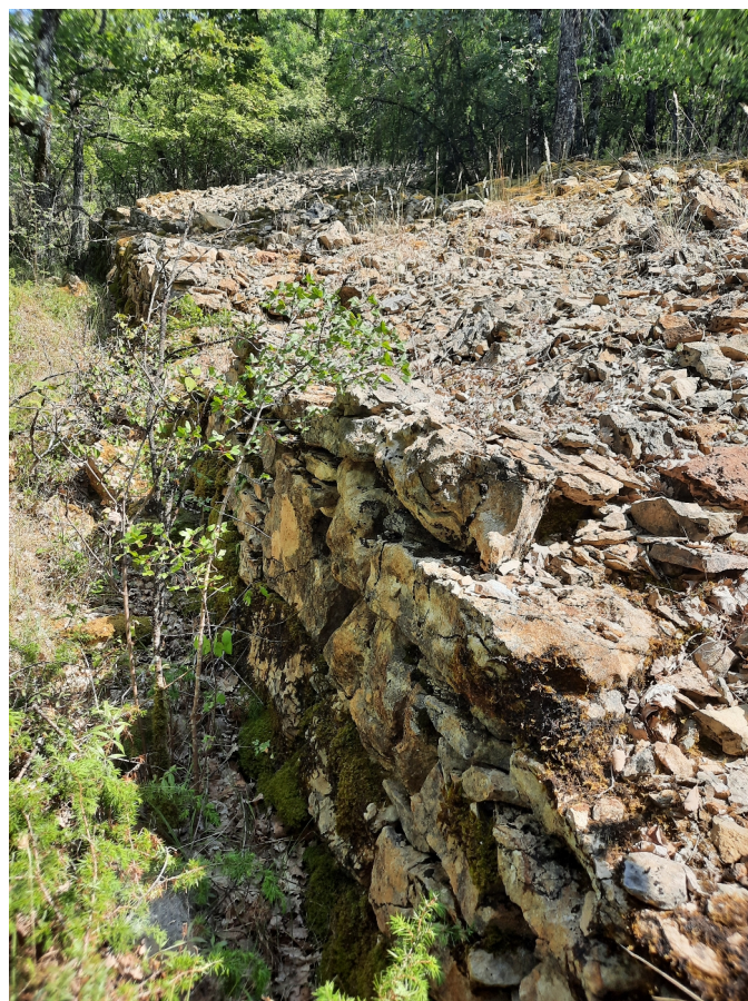
Figure 8: Prospection du secteur de la Vène (Puycelsi) : Mur de soutènement de tas d'épierrement au niveau du point n°349
