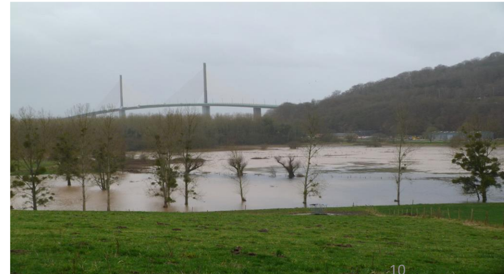
Le marais s Saint-Wandrille-Rançon inondé en 2019
