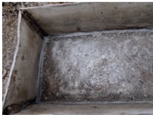
FIG. 3.80a : Détail de l'intérieur de la cuve I.112. © SAAM
