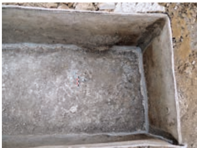
Fig. 3.80b : Détail de l'intérieur de la cuve soudure au pied I.112. © SAAM
