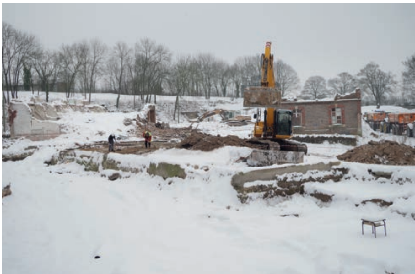
FIG. 3.1 : Janvier 2013. Décapage sous la neige, de la seconde phase de fouille des ensembles funéraires à la fin des démolitions des bâtiments de la prison, datés du XIX e siècle. © SAAM
