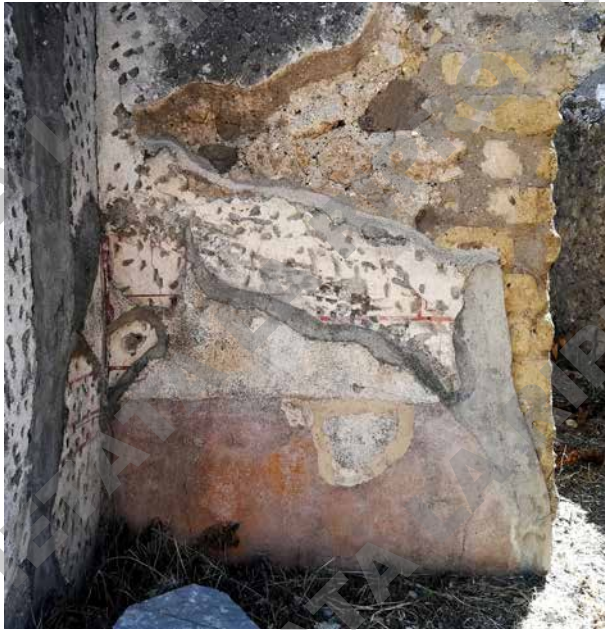
Fig. 51. Paramento N della muratura POM_ES_0393, della Casa VI 7, 1-2 (POM_068). Si vede chiaramente con l'intonaco in stile 5, sia steso al di sopra di un rivestimento parietale precedente, nel cosiddetto "Il stile schematico". Per una maggior adesione del secondo intonaco, sulla superficie del primo sono state eseguite delle picchiettature.
