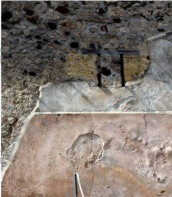
Fig. 48. Esempio di intonaco bipartito dalla facciata della Casa dei Vettii (VI 15, 1.27; POM_062).
