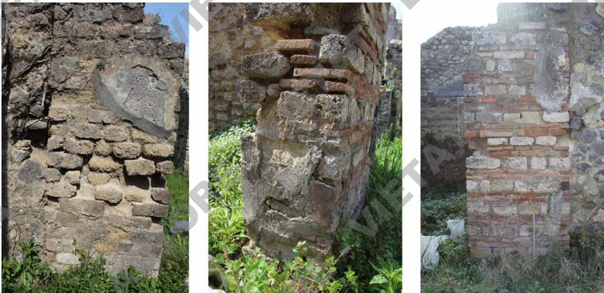
Fig. 72. Al centro, la parte inferiore dello stipite della muratura POM_ES_0100; a sinistra, il paramento S, databile al periodo pre-sismico; a destra, quello N successivo al terremoto del 62/63 d.C. Si possono notare, nell'immagine centrale, le assise non allineate tra i due paramenti.
