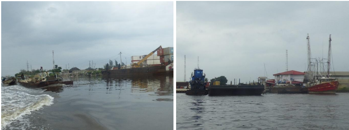
Figure 10 : unités d'extraction de sable installées sur la lagune de Lagos
