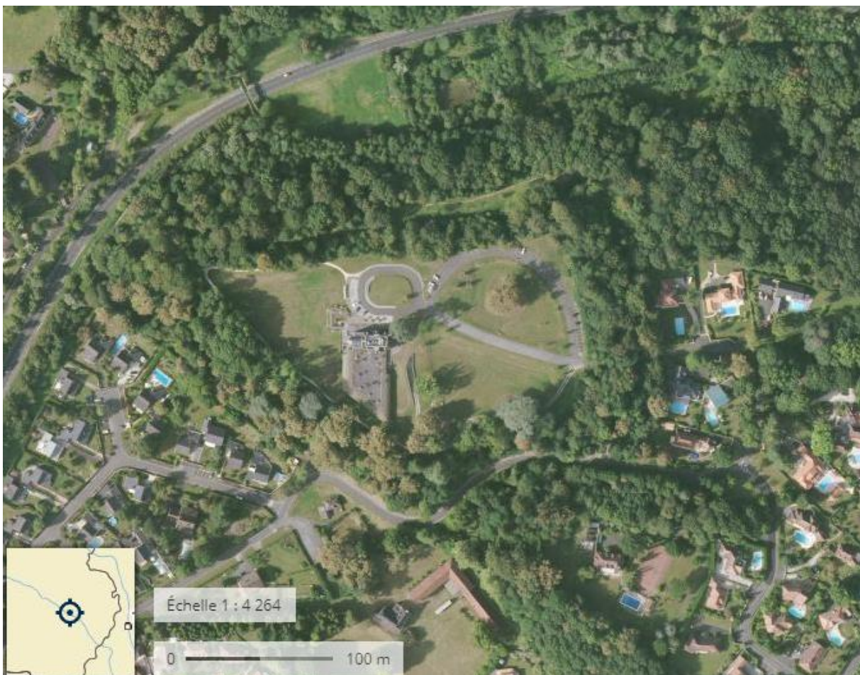
Figure 1-Lescar (64) - Mission du 24/02/2020 - Localisation de la zone couverte par les 3 vols Lidar par drone
