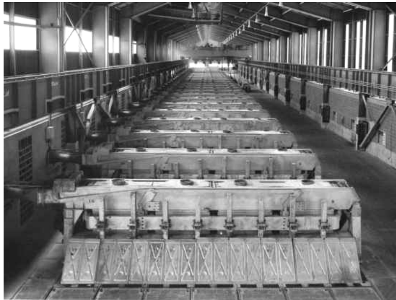
Figure 6 : Photographie d'une série de cuves d'électrolyse
